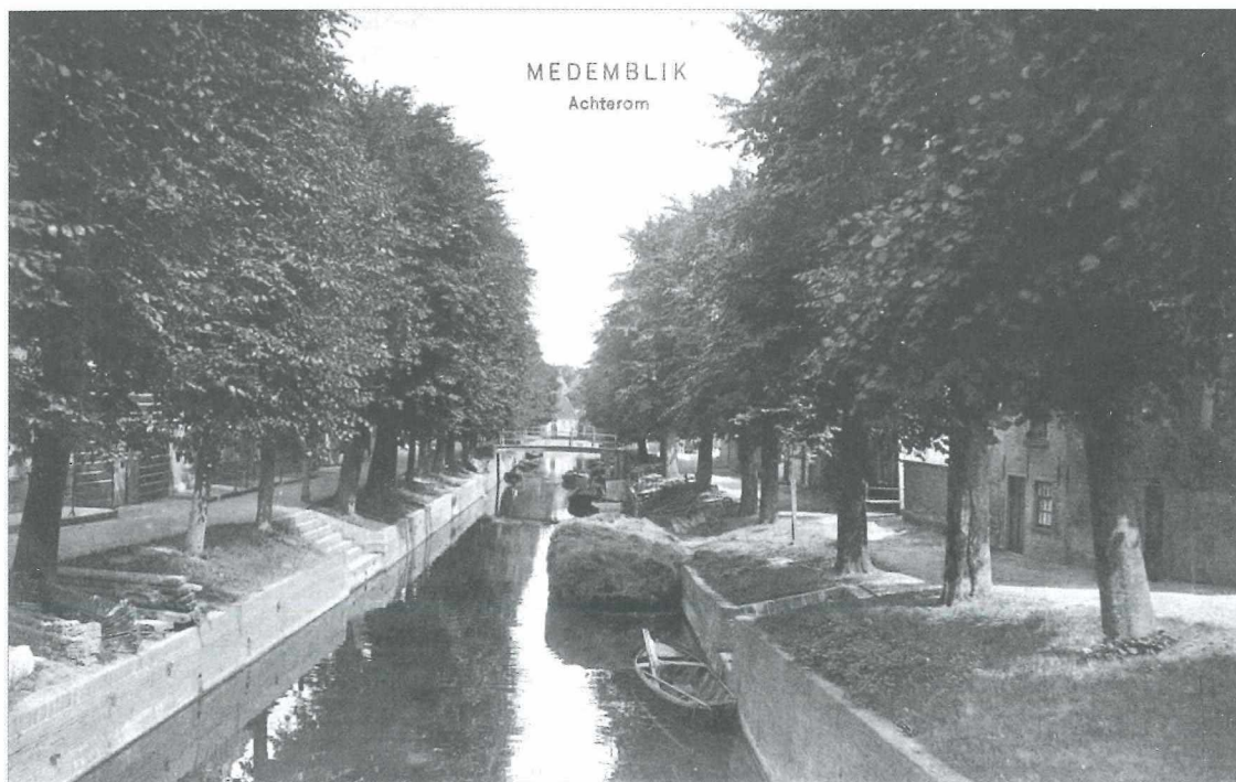
Afb.3: De Torenstraatbrug in 1900.
