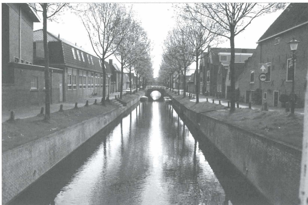
Afb.4: De Torenstraatbrug in 2012.
