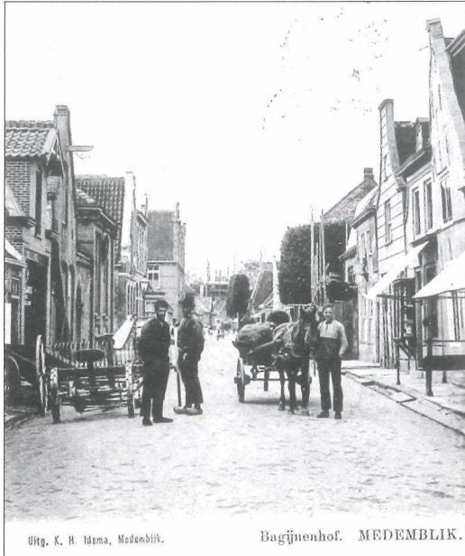
Afb.5a: In de verte de bouw van de toren van de Martinuskerk anno 1902.
