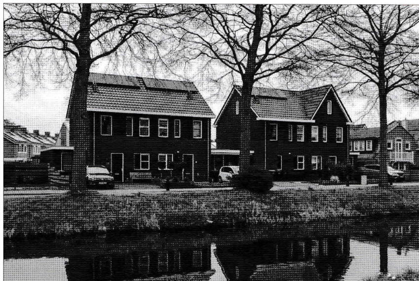
Afb.1b: Nieuwbouw aan de Korte Brake (2023).
