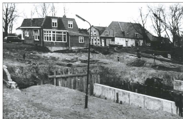
Afb. 5b: Brug- en wegreconstructie in uitvoering (1965).
