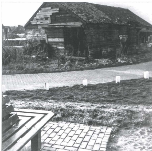
Afb. 14: De loods van baggermaatschappij De Koning (ca. 1965).
