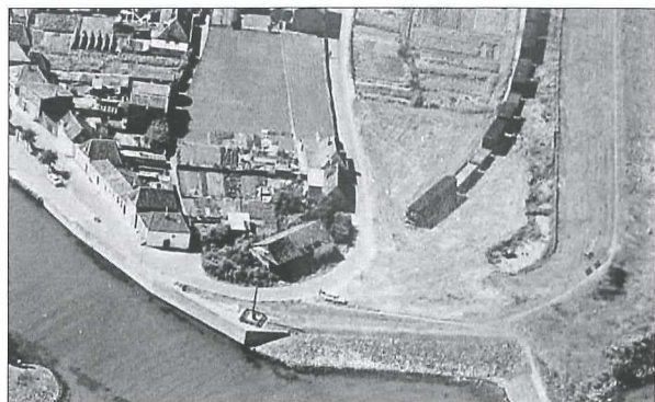
Afb. 13: Luchtfoto van het havenhoofd (ca. 1964).
