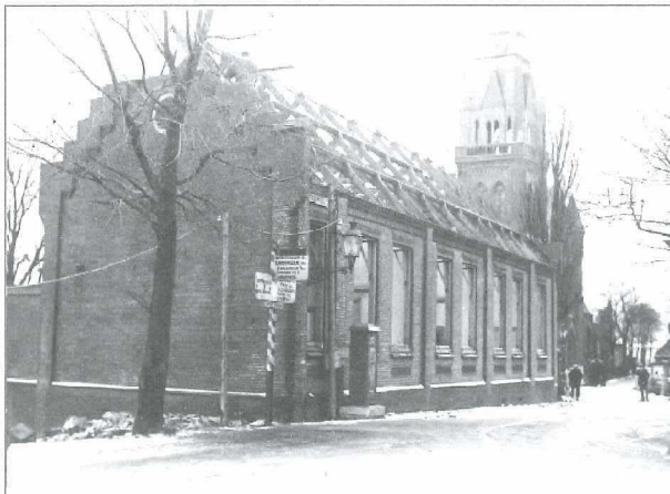
Afb. 3: De sloop van de Aloysiusschool.
