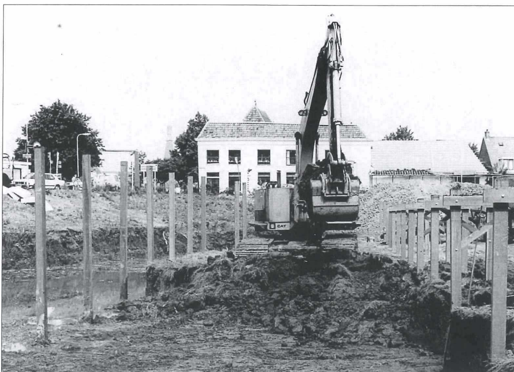
Afb. 13: De Pekelharinghaven wordt in 1988 uitgegraven en van meerpalen voorzien.
