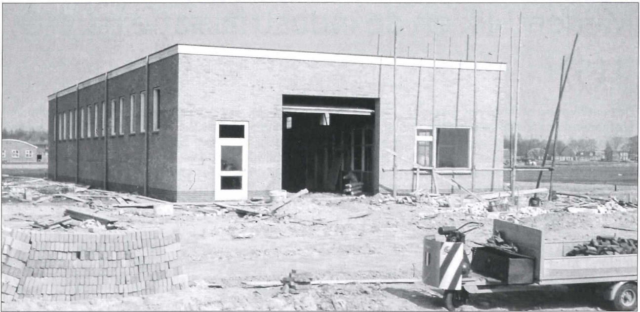
Afb. 1: Plastic Packing in aanbouw aan de Randweg (1970).
