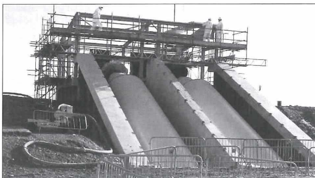
Afb.10: Plaatsing visveilig vijzelgemaal Bells & Mocketts in Engeland (2018).
