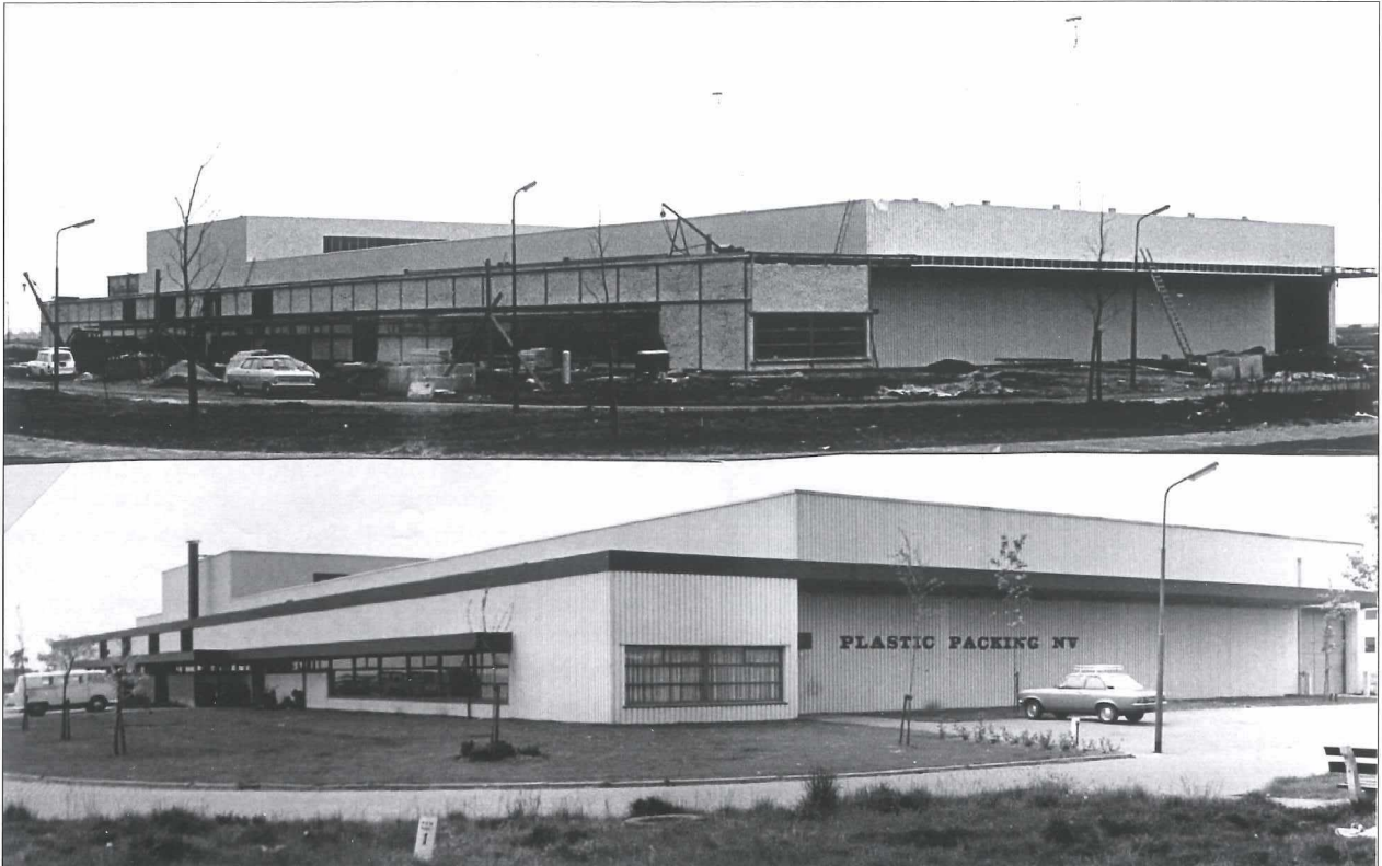
Afb. 1b: Plastic Packing in aanbouw; later Pall Medistad (ca. 1987).
