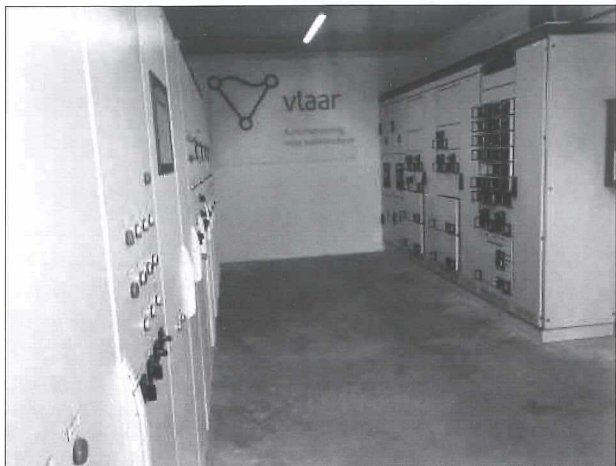
Afb.7: Gemaal C. Mantel-binnen (2016).
