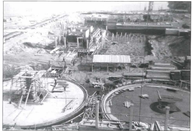
Afb.4: Bouw Waterzuivering Andijk (ca. 1965).
