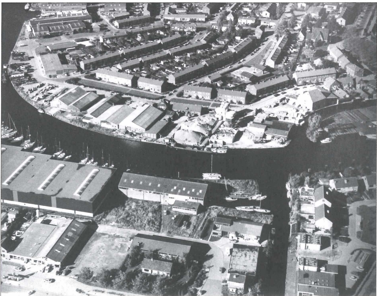
Afb.8: Luchtfoto Overlekerkanaal, Plan West, Heerdt, BBN, Jachtwerf Ten Wolde (ca. 1970).
