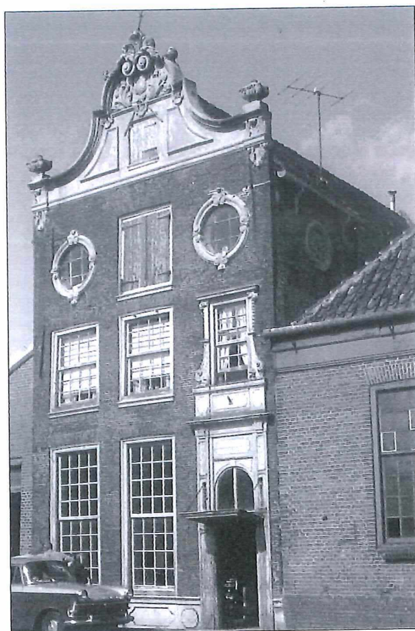
Afb.4: 1967, Vooreiland 22, landbouwmachine-fabriek Krakei.
