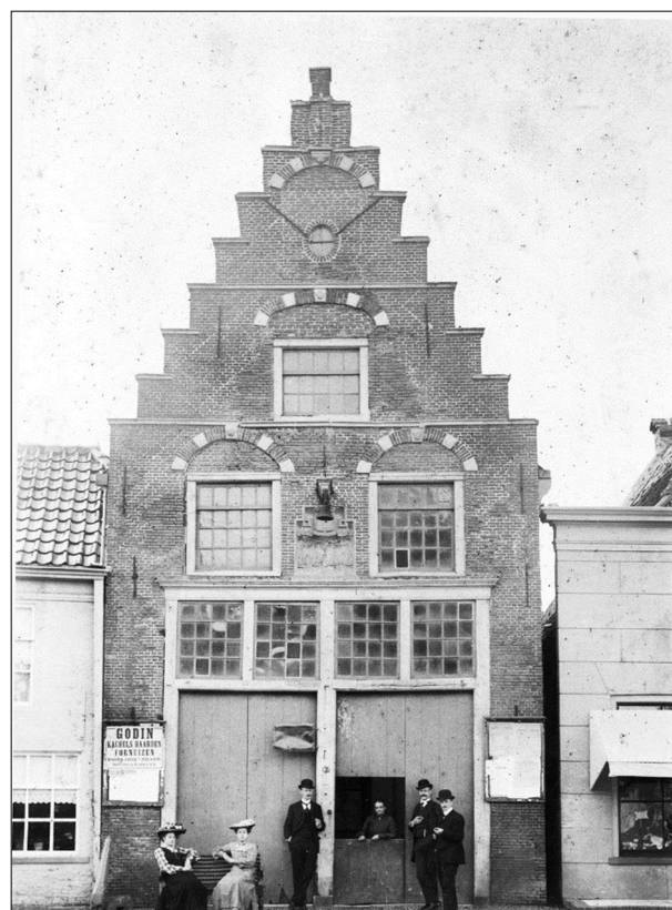
Afb. 1: Het Waaggebouw in 1890.
