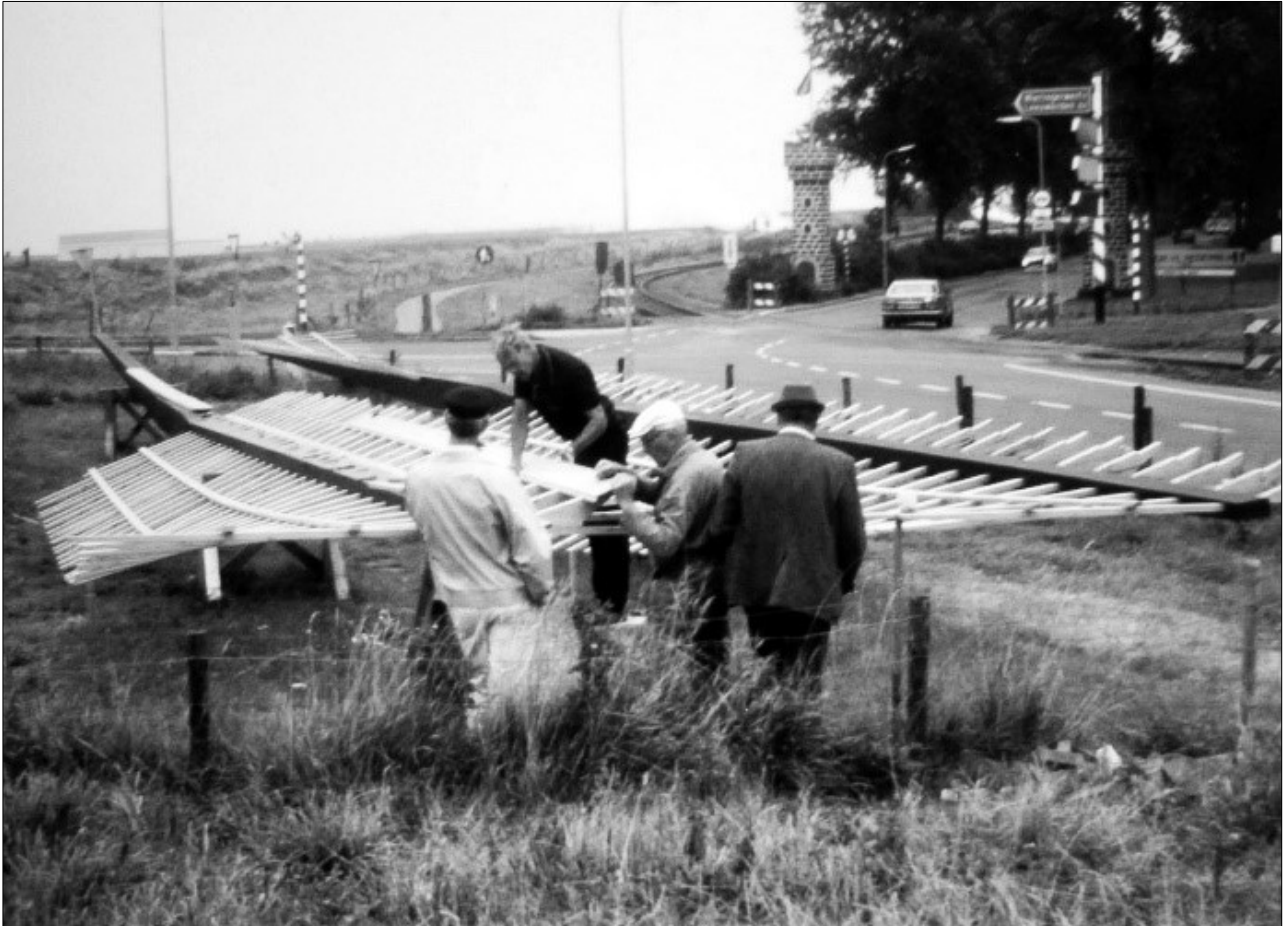
Afb. 6: Roeden en hekwerk. De man met de hoed is Jaap van Leverink. Jan Gorter (met pet) en Sjaak Berkhout zijn bezig met het hekwerk. Een onbekende man kijkt toe. Op de achtergrond de versiering in verband met 'Medemblik 700 jaar stad' (1989).
