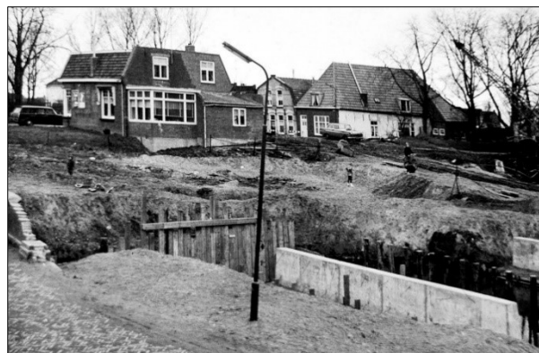
Afb. 5b: Brug- en wegreconstructie in uitvoering (1965).
