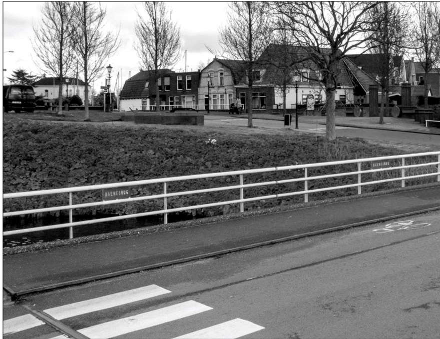
Afb.5c: De afgeronde reconstructie van een voormalig verkeerskundig knelpunt (2021).
