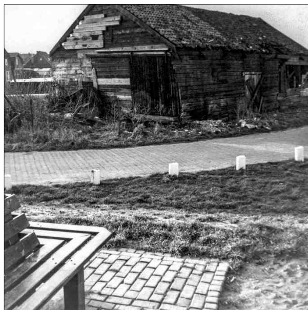
Afb. 14: De loods van baggermaatschappij De Koning (ca. 1965).
