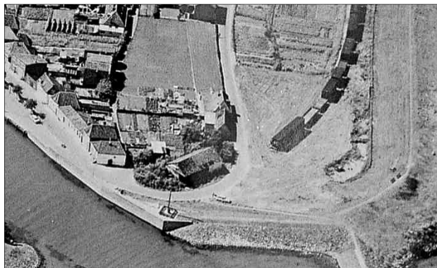
Afb. 13: Luchtfoto van het havenhoofd (ca. 1964).
