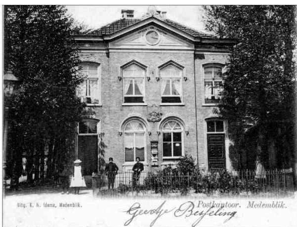
Afb.2: Het in 1869 gebouwde postkantoor te Medemblik. Het postkantoor moest in 1910 plaats maken voor een nieuw postkantoor met een bovenwoning voor de directeur (ca. 1900).
