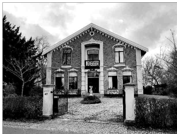
Afb.3: Pastorie te Aartswoud (1873). De voorgevel wordt verticaal geleed door een middenrisaliet en hoekpilasters. Alle vensters hebben een getoogde bovenzijde en met acanthusbladeren gedecoreerde wenkbrauwen. Boven de deur een op consoles rustend balkon met balustrade. In de nok een radvenster. De kap heeft gesneden windveren (2018).
