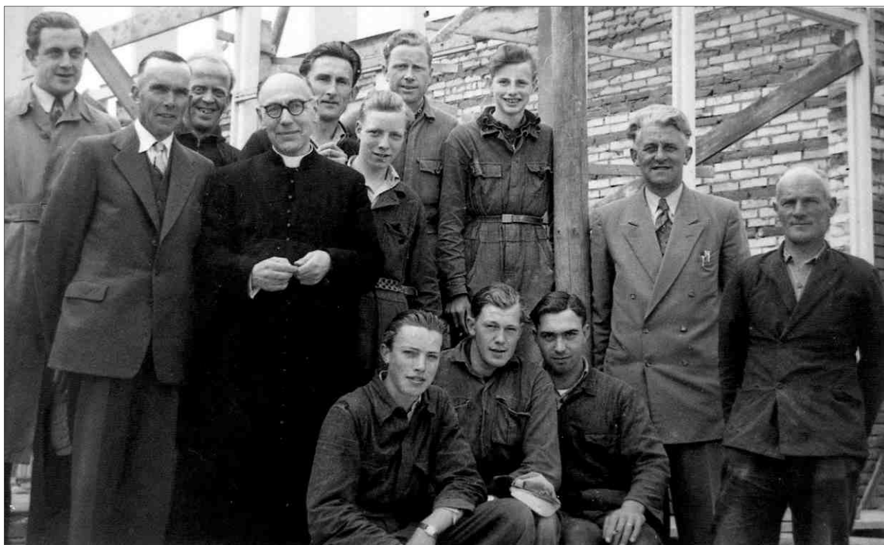
Afb. 1: Aannemer, pastoor en werklieden t.g.v. de eerste steenlegging van de Piussschool van Andijk-West. Achter (v.l.n.r.): Wim Vlaming (architect, Medemblik), Jacob Botman (aannemer), Piet Sijm, pastoor Minneboo, Jan Botman (de Streek), Theo Bakker, Simon Tensen, Jan Dekker Klz., Hos Langerijs (opzichter, Medemblik), Piet Dudink. Voor (v.l.n.r.): Arie Botman Jacz., Loek Pouw en Frans Maas (ca. 1954).
