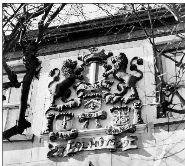
Afb. 4: De forse gevelsteen op de zuidgevel van het Medemblicker Tolhuis (1949).
