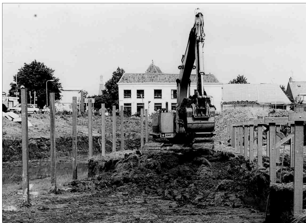
Afb. 13: De Pekelharinghaven wordt in 1988 uitgraven en van meerpalen voorzien.
