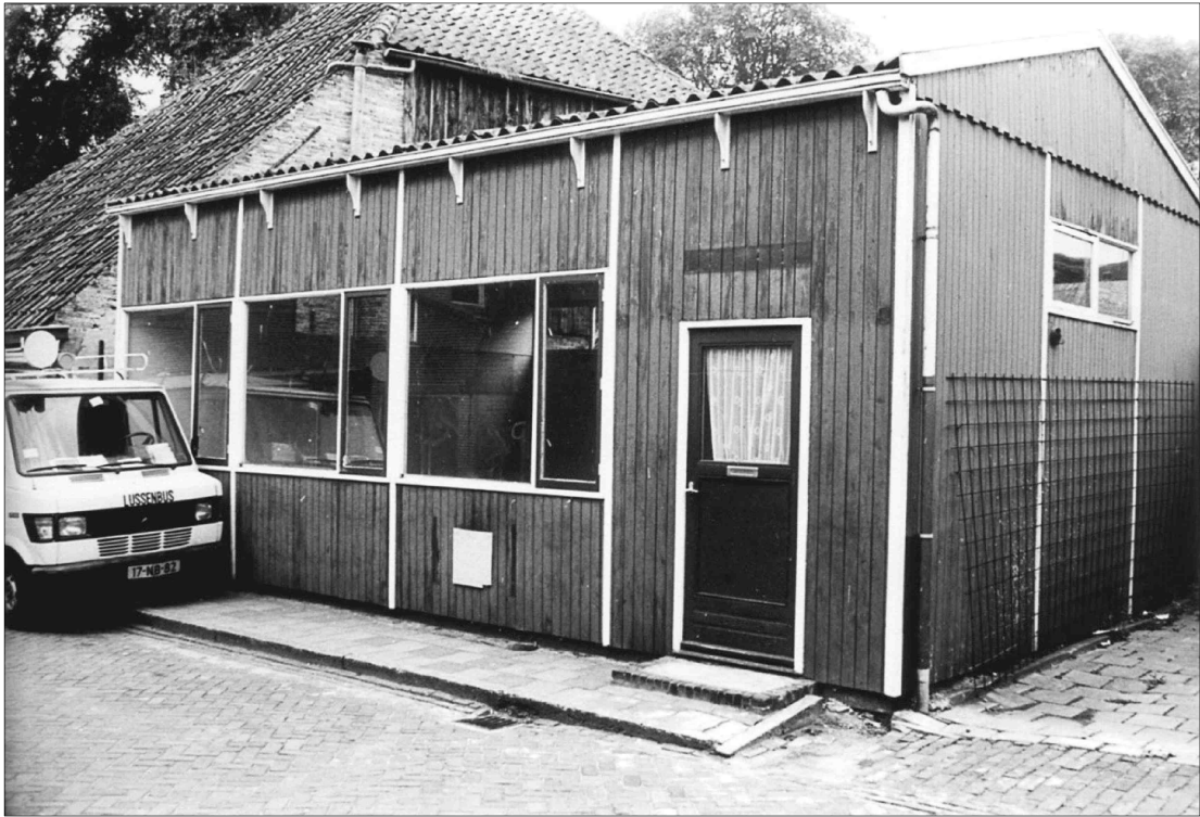
Afb. 10: Voormalig verenigingsgebouw van Harmonie Crescendo in de Kruisstraat (1982, vlak voor de sloop).
