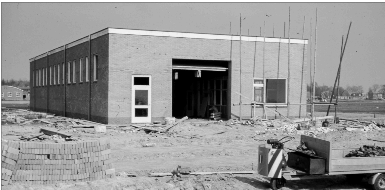
Afb. 1: Plastic Packing in aanbouw aan de Randweg (1970).
