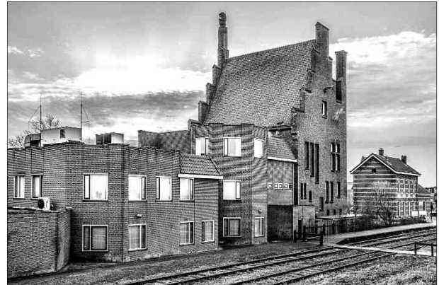
Afb.9: De nieuwe vleugel (2010).
