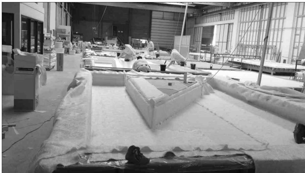
Afb. 15: Werk aan de gevel voor het Stadskantoor Utrecht.
