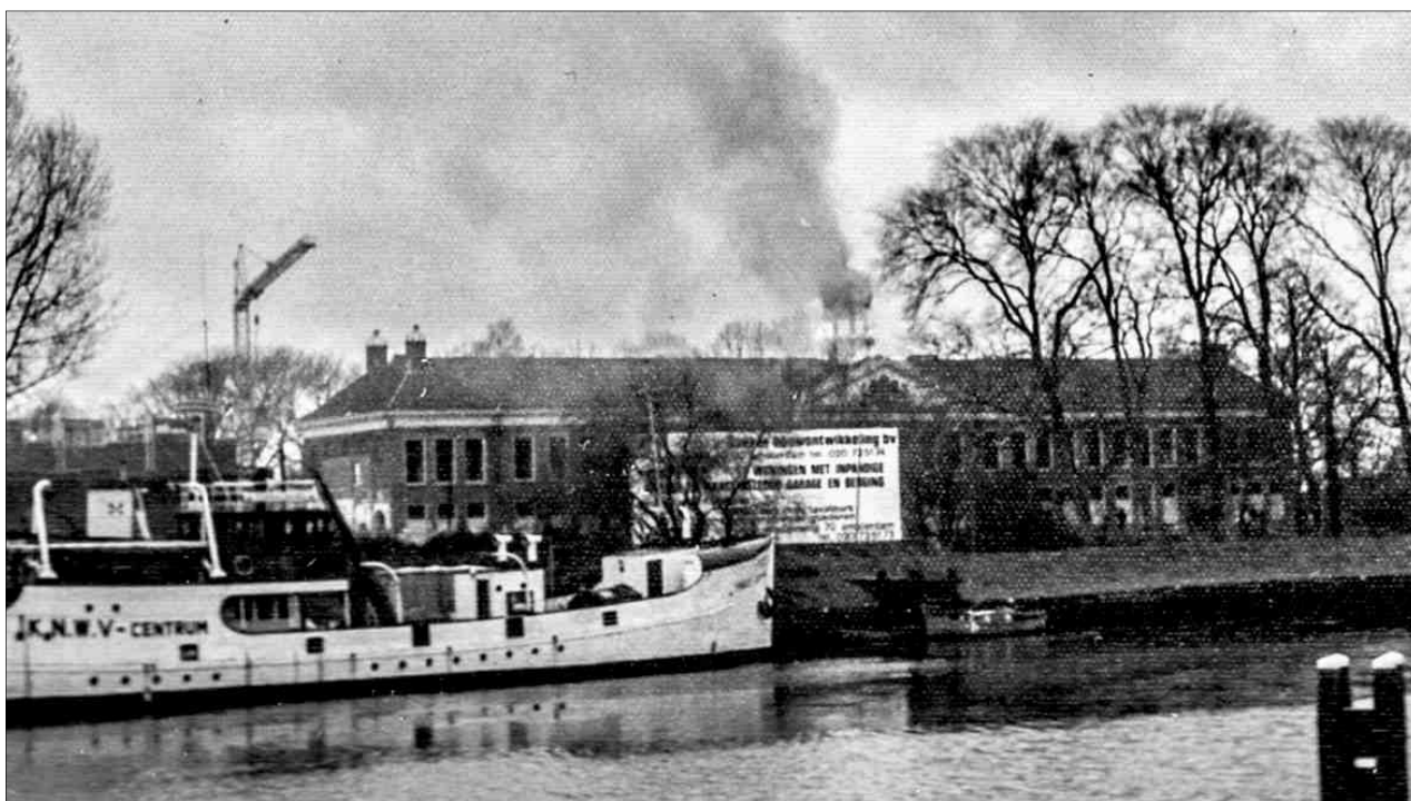
Afb.24: 1976, brand in het koepeltje van het voormalige Provinciaal Ziekenhuis, op de voorgrond het opleidingsschip Juliana.
