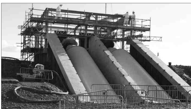
Afb.10: Plaatsing visveilig vijzelgemaal Bells & Mocketts in Engeland (2018).
