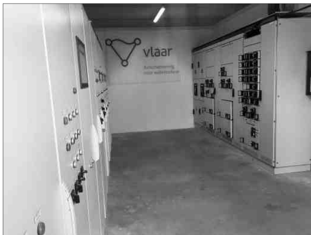
Afb.7: Gemaal C. Mantel-binnen (2016).
