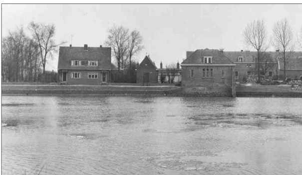
Afb. 10: Zuidelijke havenkering ter hoogte van het voormalige poortgebouw (1963).
