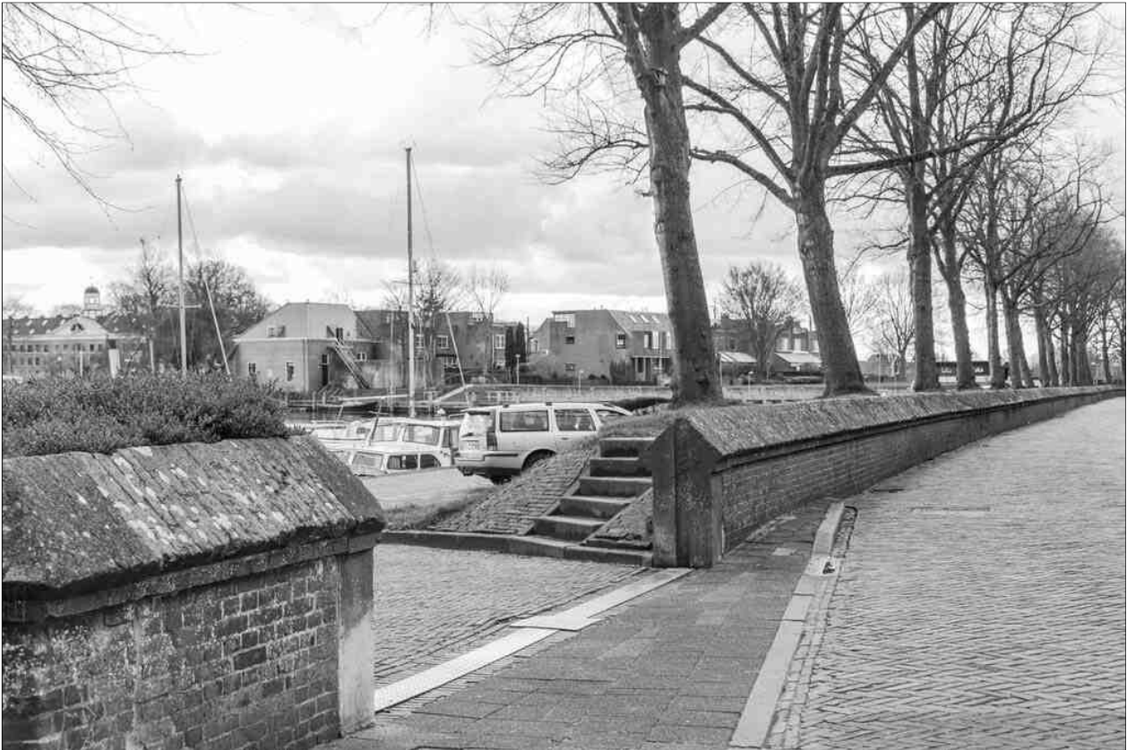
Afb.9: De Turfhoek met ook hier de keerwand incl. coupure (2016).
