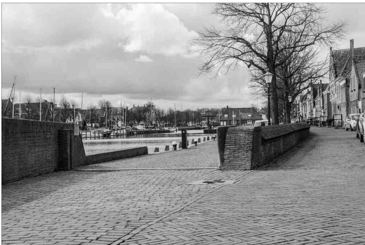
Afb.4: Het begin van de Oosterhaven(dijk) met in het midden de gemetselde keerwand (2016).
