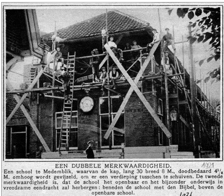
Afb. 6a: In 1921 werd het dak van het schoolgebouw 4,5 meter omhoog gevijzeld.
