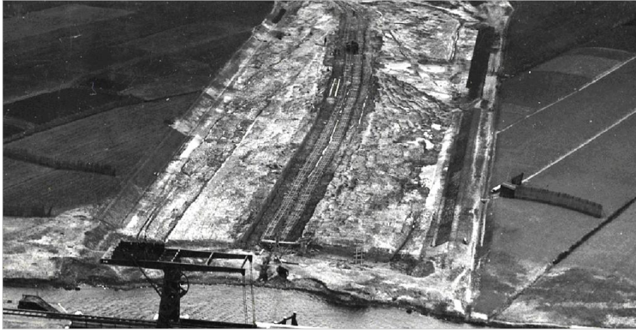
Afb. 18: Graafwerkzaamheden ten behoeve van het kanaal (begin 1930).
