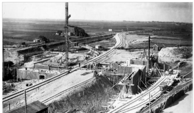
Afb.11: De spoorlijn is tijdelijk omgelegd (medio 1929).
