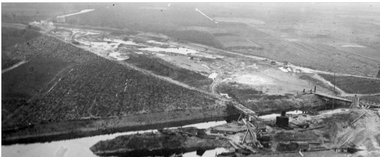
Afb. 17: De aanlegwerkzaamheden in beeld (najaar 1929).
