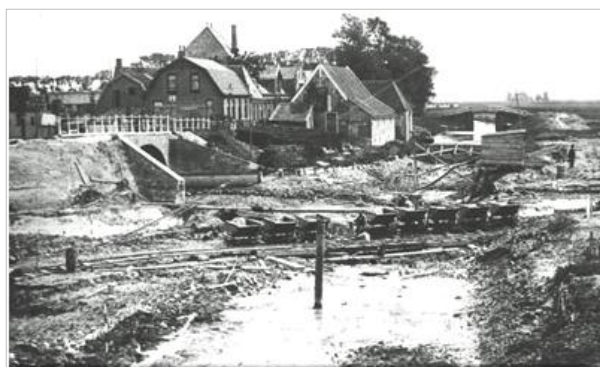
Afb.4: Grondwerk ten behoeve van de omlegging van de Groene Singel.
