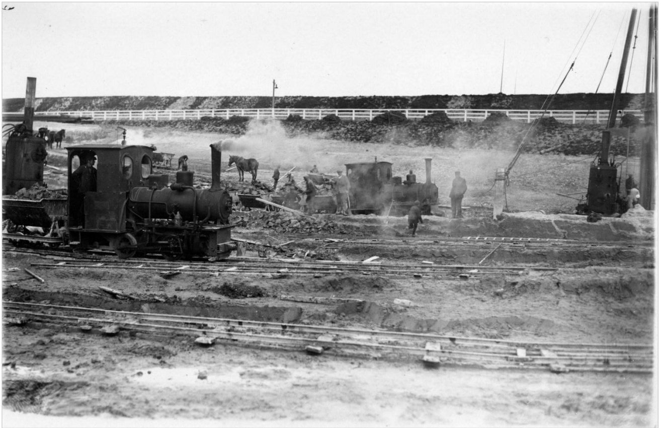
Afb.9: De ontgraving van de sluisput in volle gang (zomer 1928).
