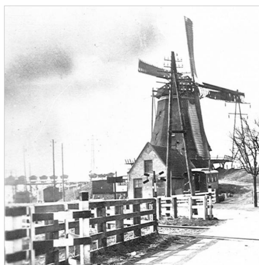
Afb. 15: Het transport van grond in kiepkarren over de tijdelijke houten spoorbrug (links op de foto).
