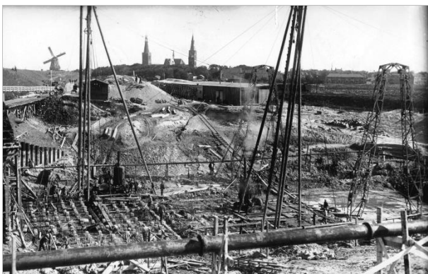
Afb.10: De heiwerkzaamheden op de bodem van de sluiscolk (tweede helft 1928).
