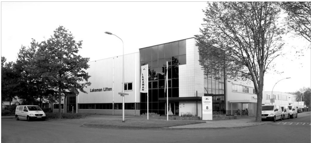
Afb.6: Bedrijfspannd van Lakeman Liften in Katwijk anno 2012.
