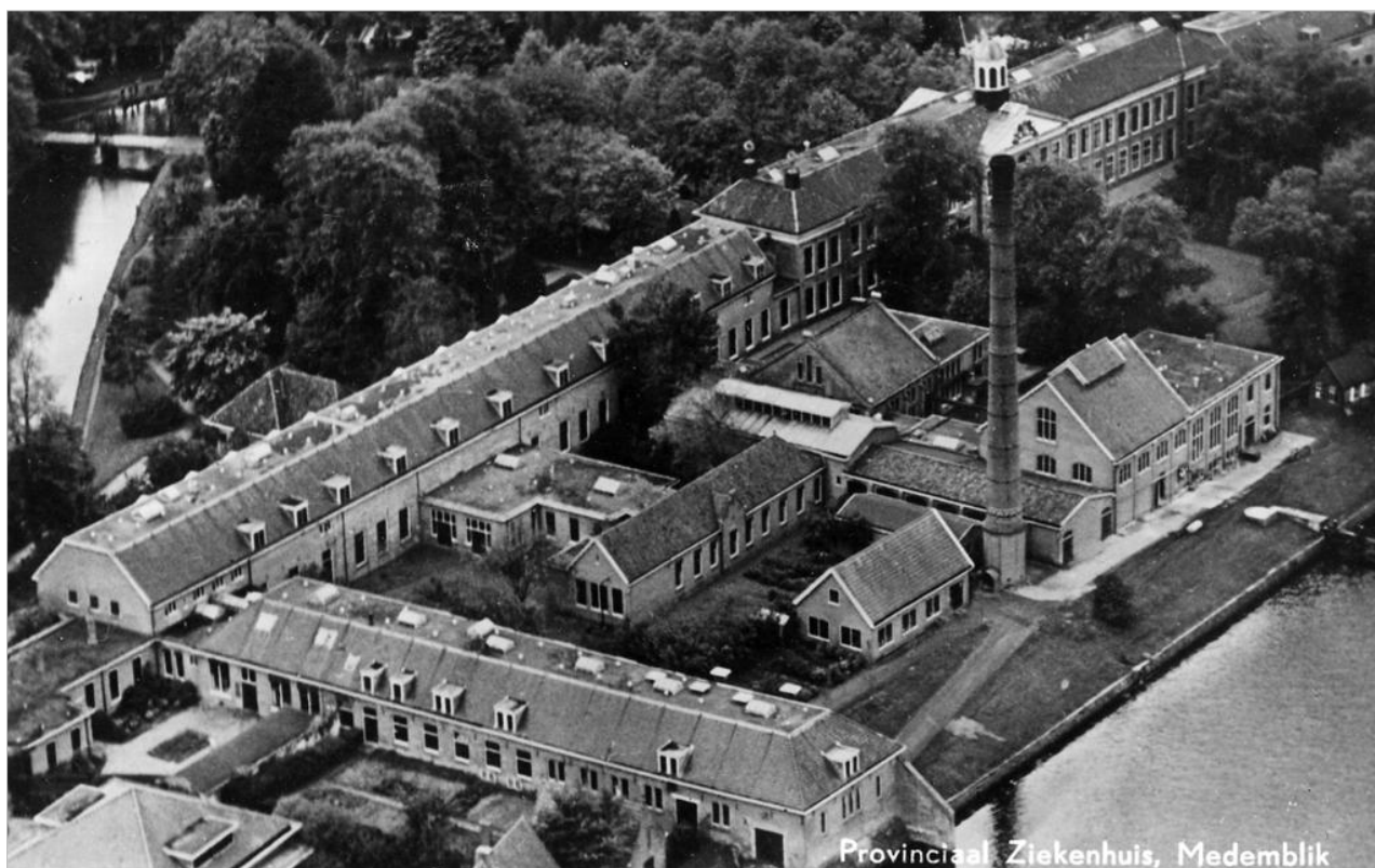
Afb.9: Luchtfoto van het Provinciaal Ziekenhuis.
