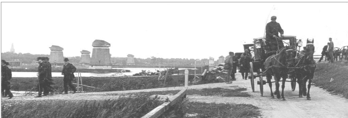
Afb.9: Gasten arriveren om het uitgebreide gemaal in gebruik te nemen.
