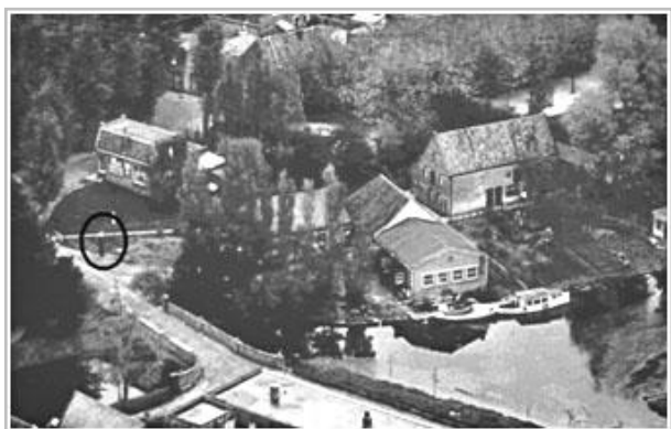
Afb. 11: Het bedrijfscomplex van de gebr. Loos met in de cirkel de pompzuil aan de Hoogsteeg (ca. 1960).
