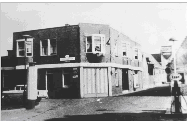
Afb. 18: De garage van de fa. Botman en de bijbehorende Esso-pomp (1965-1970).
