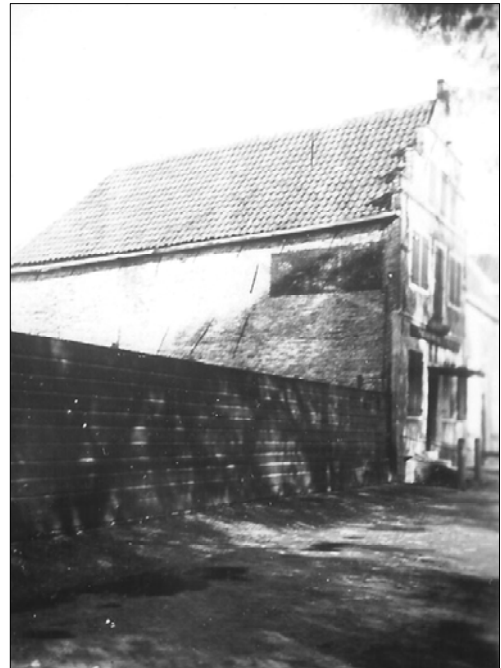
Een schutting om de afgebrande fabriek aan de Oosterhaven. Foto: J.C. van Leverink.
