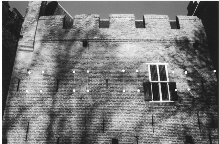
De oorspronkelijke lage weergang, kanteling (witte stippen) en schietgaten zijn, tijdens de laatste restauratie, in het metselwerk geaccentueerd. (Foto: Ben Dijkhuis).
