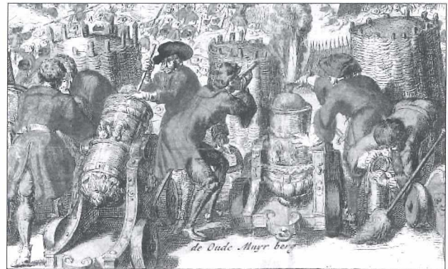
Afb.8: Detail van de ingekleurde kopergravure van het Beleg van de Waalse stad Namen in 1695 door Koning-Stadhouder Willem III. De mortierkanonnen staan tussen schanskorven. Links wordt met een kanonwisper het mortier schoongemaakt, in het midden wordt de hoek gemeten waaronder het booggeschut moet schieten, rechts wordt de tijdbuis van de granaat aangestoken.
