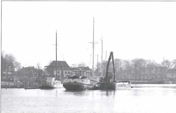
Afb. 1: Impressie van het baggerwerk in de haven van Medemblik, 2016.
