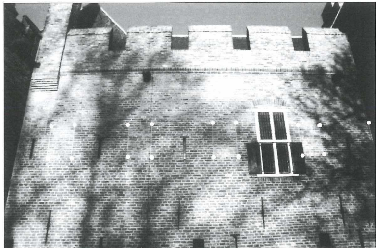
De oorspronkelijke lage weergang, kanteling (witte stippen) en schietgaten zijn, tijdens de laatste restauratie, in het metselwerk geaccentueerd. (Foto: Ben Dijkhuis).
