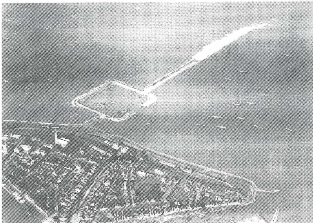
Afb. D. Oktober 1927; dijk rond gemaalput bijna gesloten (foto: A. Kamma)
