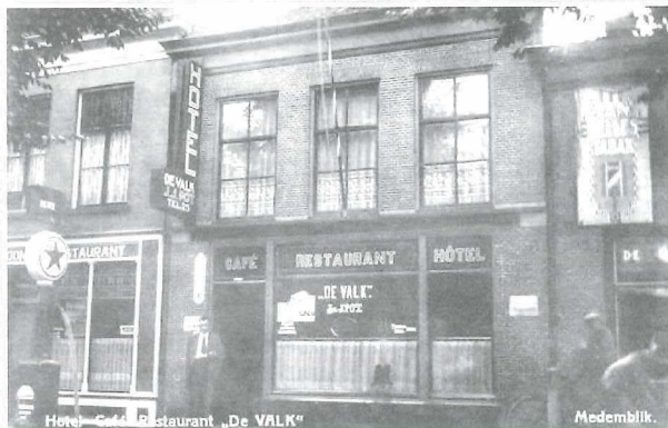
Afb. 2: De Caltex-pomp ter hoogte van Café De Valk (begin jaren dertig).
