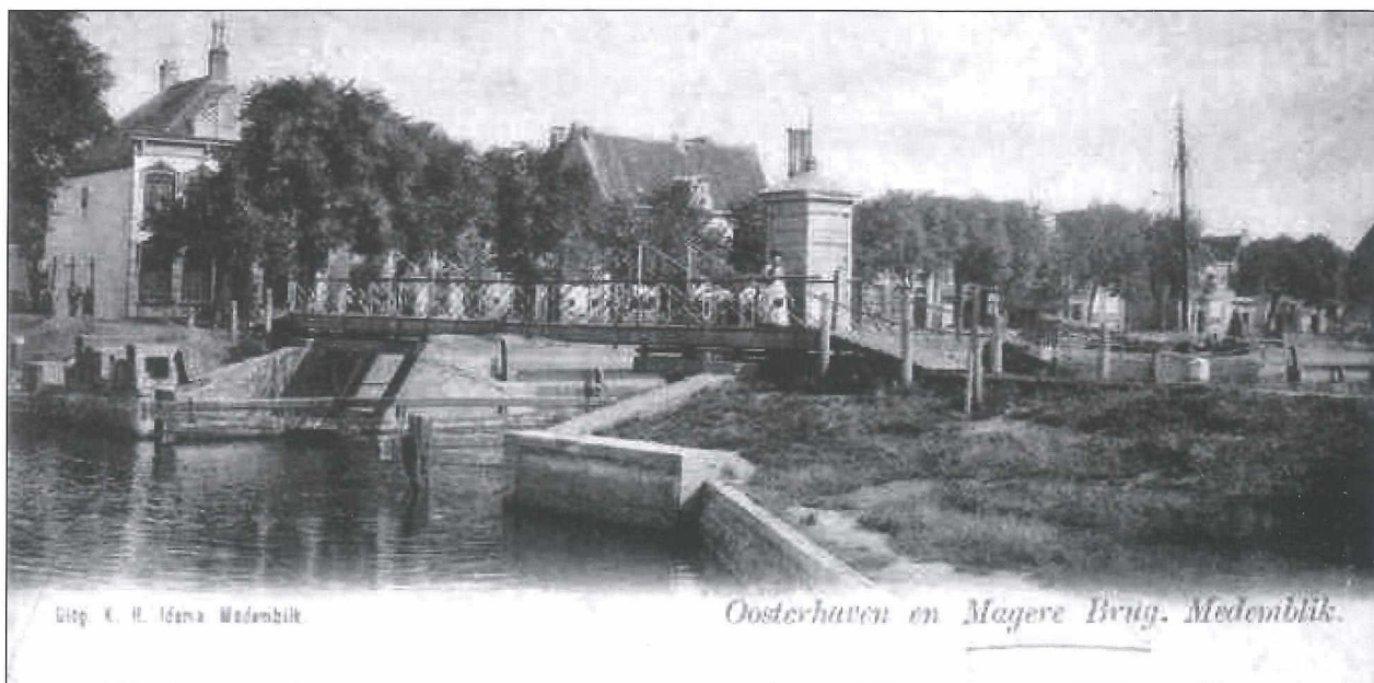
Afb.1: De landhoofden met rolbrug in de Oosterhaven omstreeks 1900 waartussen voorheen de houten schipssluisdeur kan worden afgezonken. Links op de foto het pand dat later café Het Swarte Woifke zou worden.
