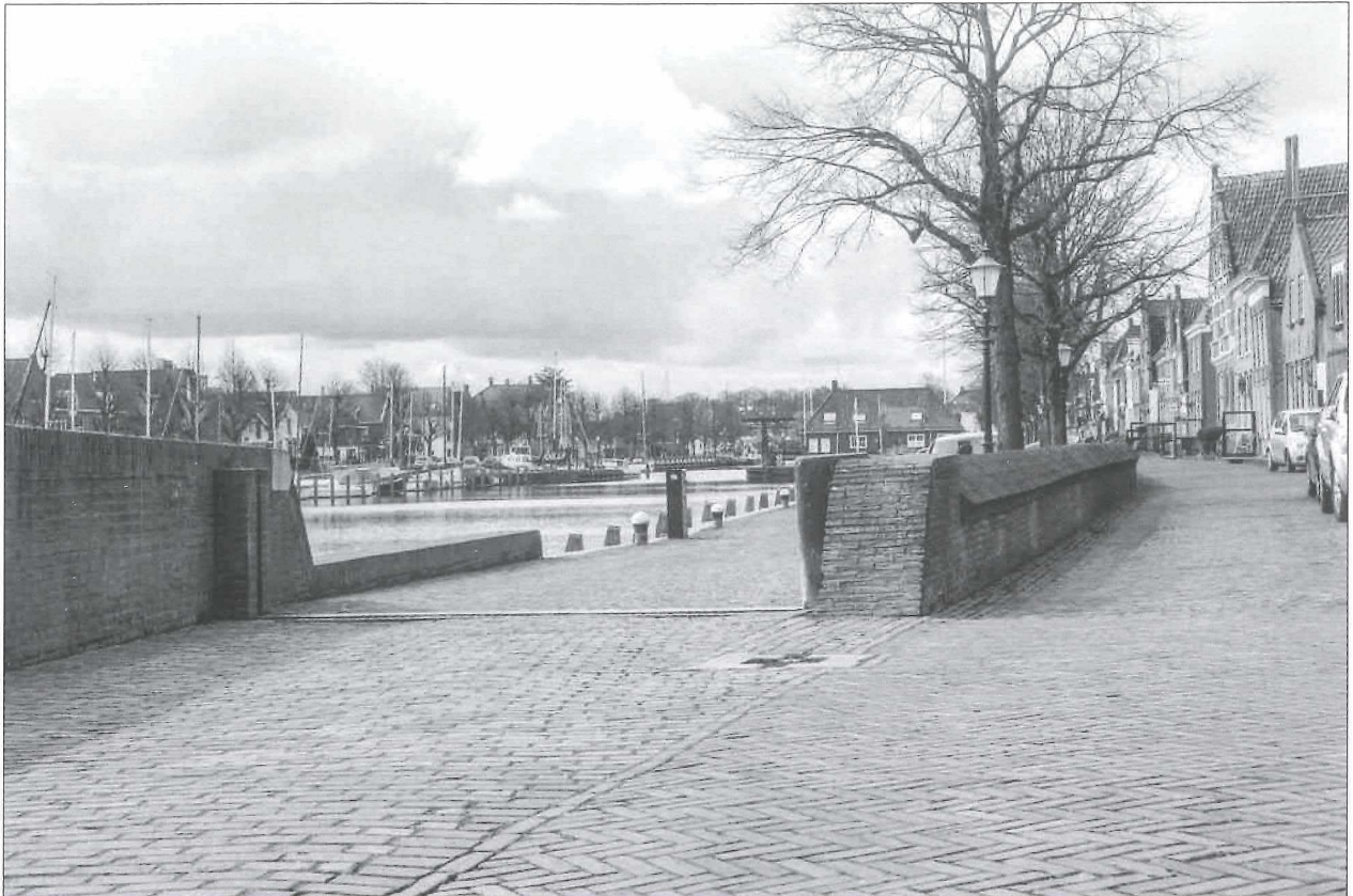
Afb.4: Het begin van de Oosterhaven(dijk) met in het midden de gemetselde keerwand (2016).
