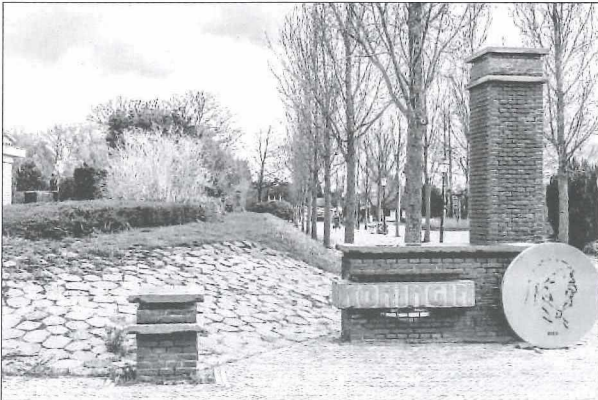
Afb. 13: De havenkering (met voor het gezicht een stukje steenbekleding) in het Emmapark links van de entree richting Theehuis (2016).
