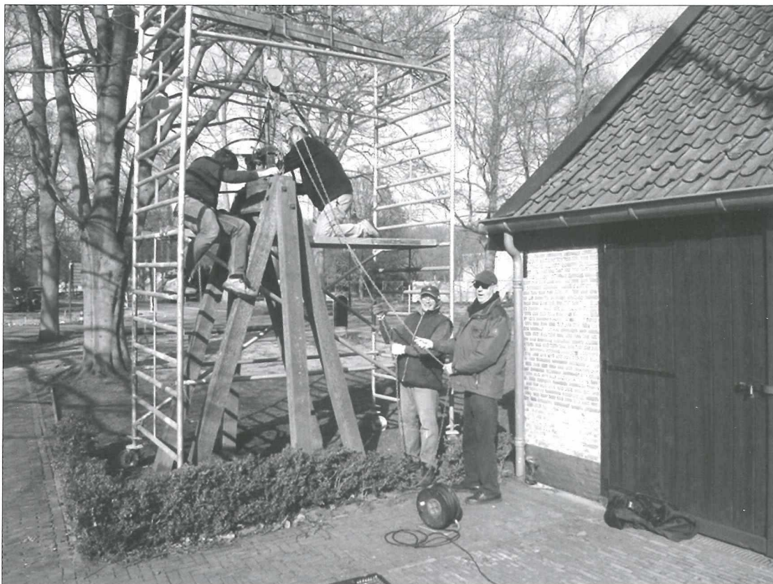
Afb.3: De klok wordt voorzichtig naar beneden getakeld.
