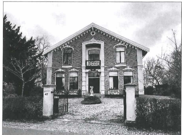
Afb. 3: Pastorie te Aartswoud (1873). De voorgevel wordt verticaal geleed door een middenrisaliet en hoekpilasters. Alle vensters hebben een getoogde bovenzijde en met acanthusbladeren gedecoreerde wenkbrauwen. Boven de deur een op consoles rustend balkon met balustrade. In de nok een radvenster. De kap heeft gesneden windveren (2018).
