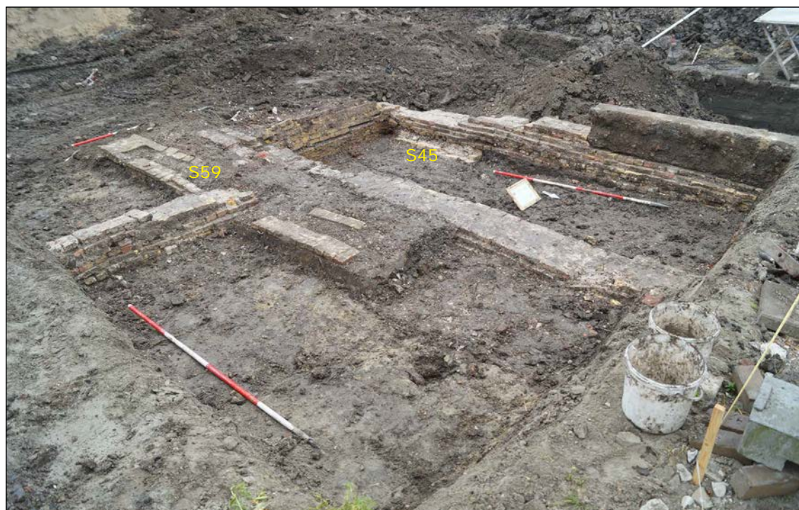
69. Overzicht van de bakstenen funderingen in vlak 1 van werkput 4. De meeste bfunderingen zijn van het Martinusgesticht. Tussen en onder die funderingen zijn oudere muren (S45, S59) zichtbaar.
