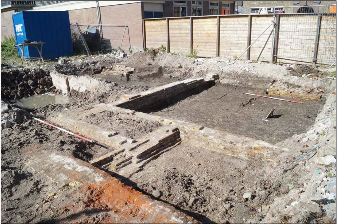
79. De zware bakstenen funderingen van het Martinusgesticht.
