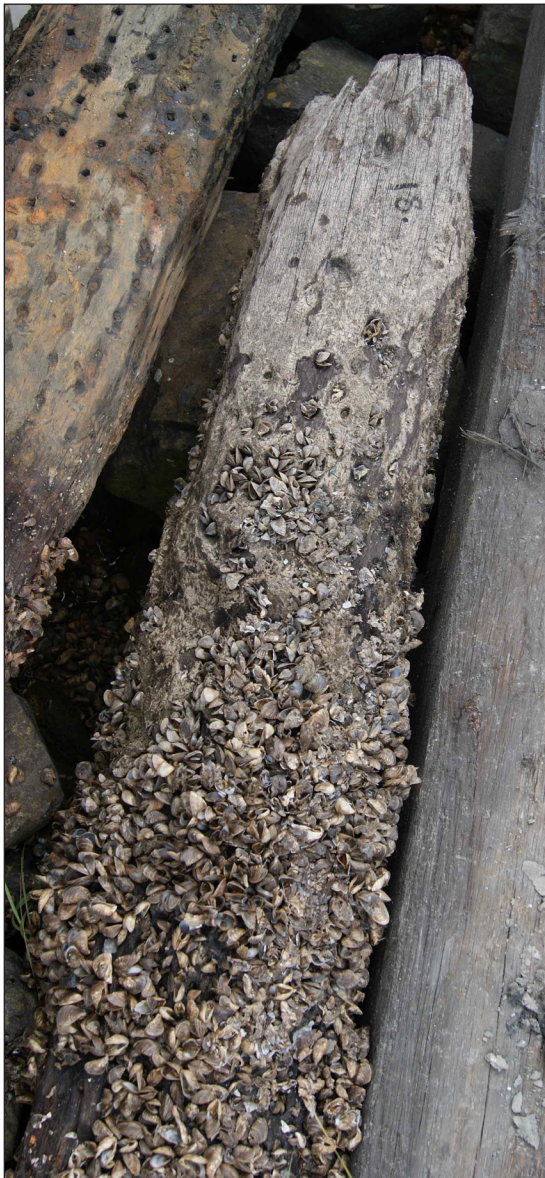
Afb. 15 Een paalkop met aangroei van zoetwatermosselen.
