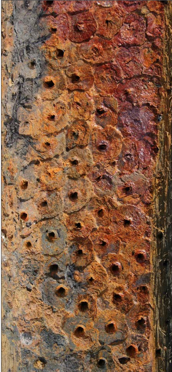
Afb. 12 Detail van een paal met verroestte en verkitte koppen en verdwenen angels.
