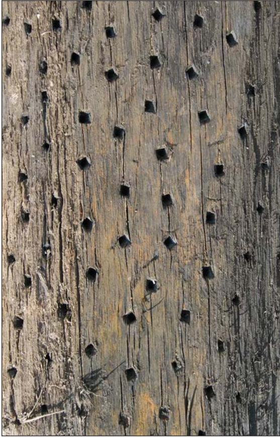
Afb. 7 Detail van een wormspijkerpaal met vierkante en rechthoekige spijkergaten.
