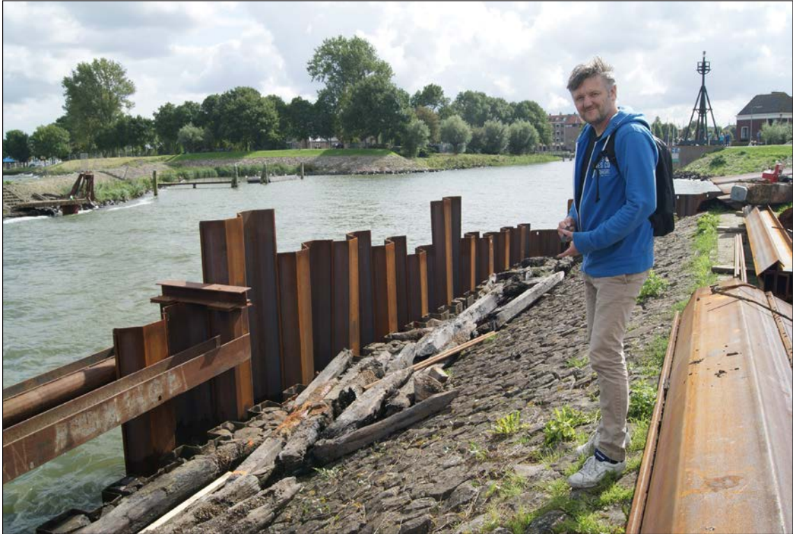
Afb. 28 Historicus Peter Swart op het havenhoofd in Medemblik, waar zowel een steenglooiing als een palenrij met paalwormspijkers was aangebracht. Daarachter is de nieuwe stalen damwand zichtbaar.
