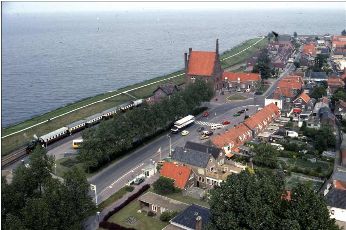
Afb. 2 De Oude Haven, de Westfriese Omringdijk en rechts aan het einde het havenhoofd in het IJsselmeer. Foto vanaf de toren van de Bonifaciuskerk rond 1978.
