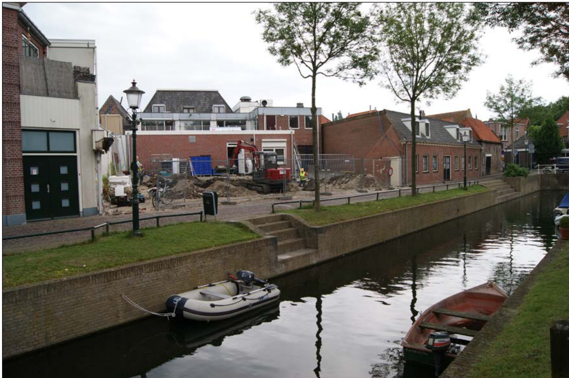
32. De onderzoekslocatie Achterom 14 in 2011.
