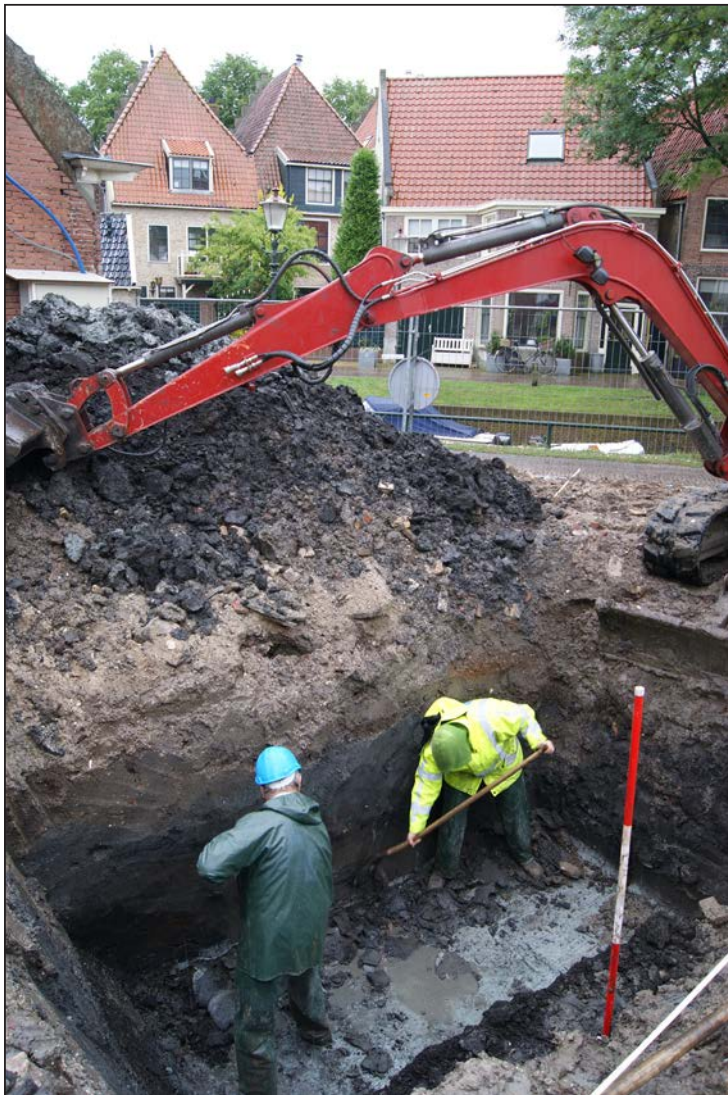
35. Aanleg profiel (bijlage 4 nr. 3) vak 1 werkput 2.
