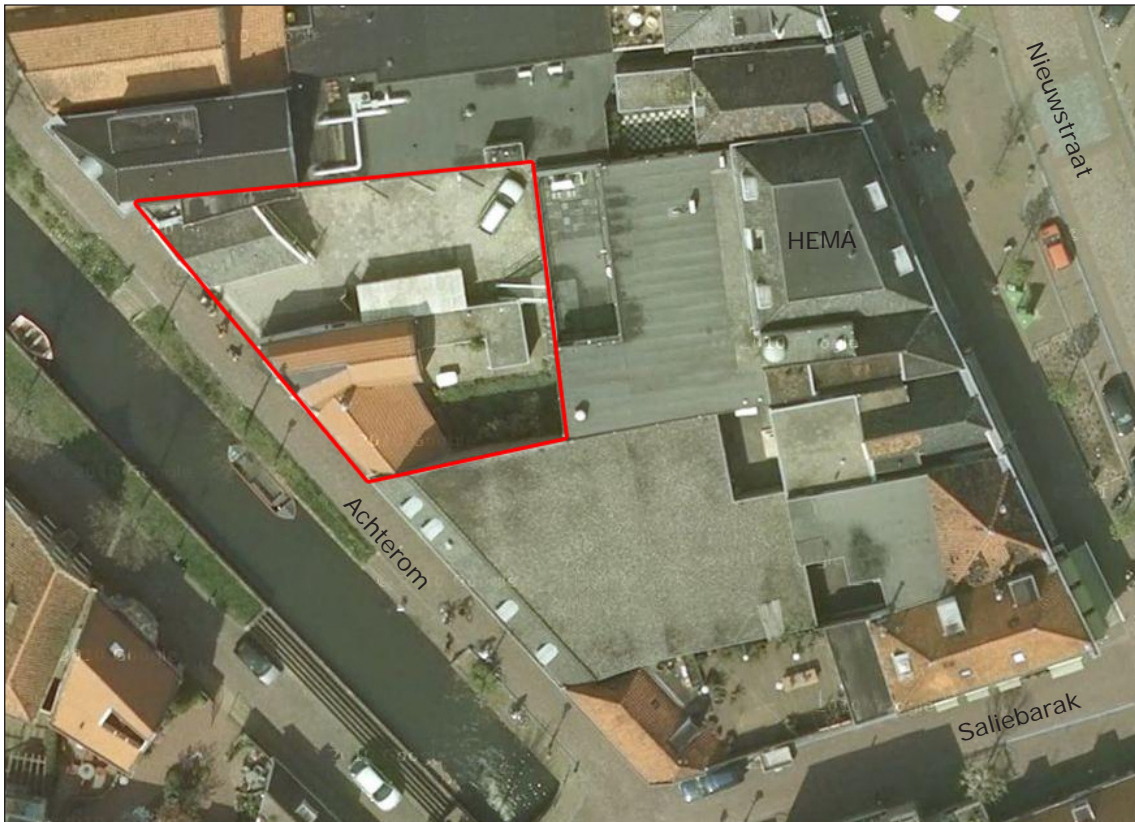
2. Luchtfoto met binnen de rode contour de onderzoekslocatie Achterom 14 voorafgaand aan de sloop van de opstallen in 2011.
