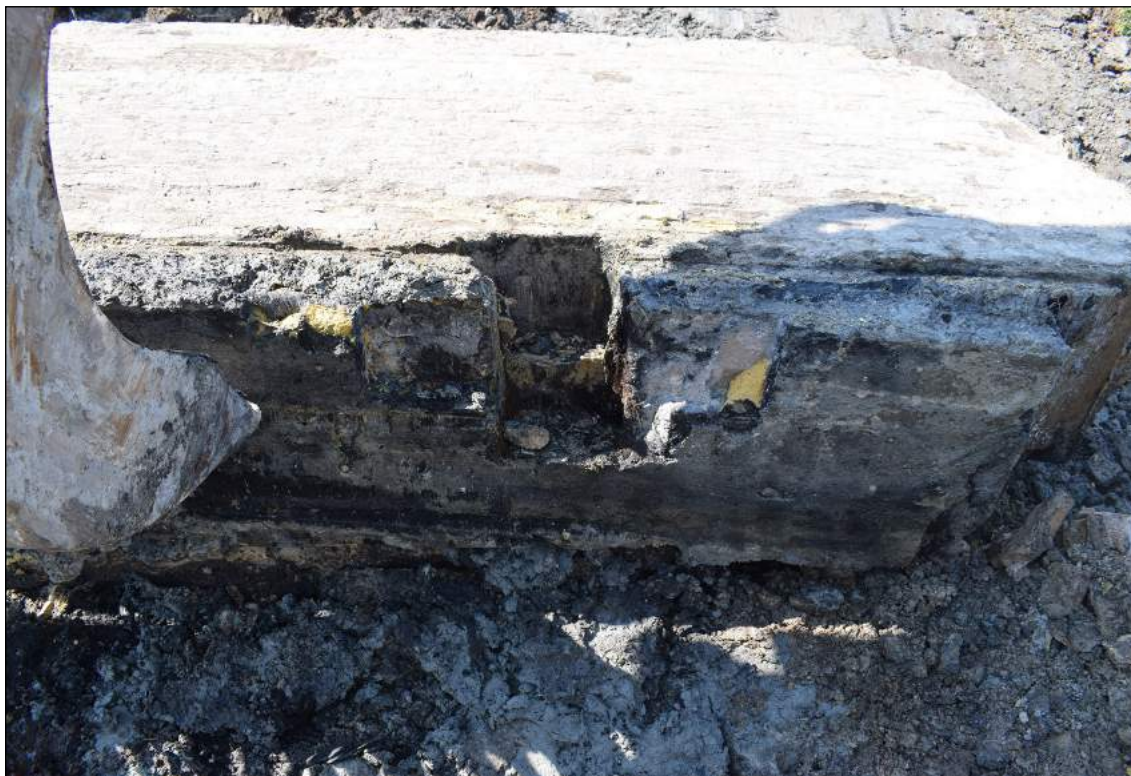
Afb. 4.39. In de onderzijde van de vijzelbak waren sponningen gemaakt om de kessen en zwalpen te bevestigen.
