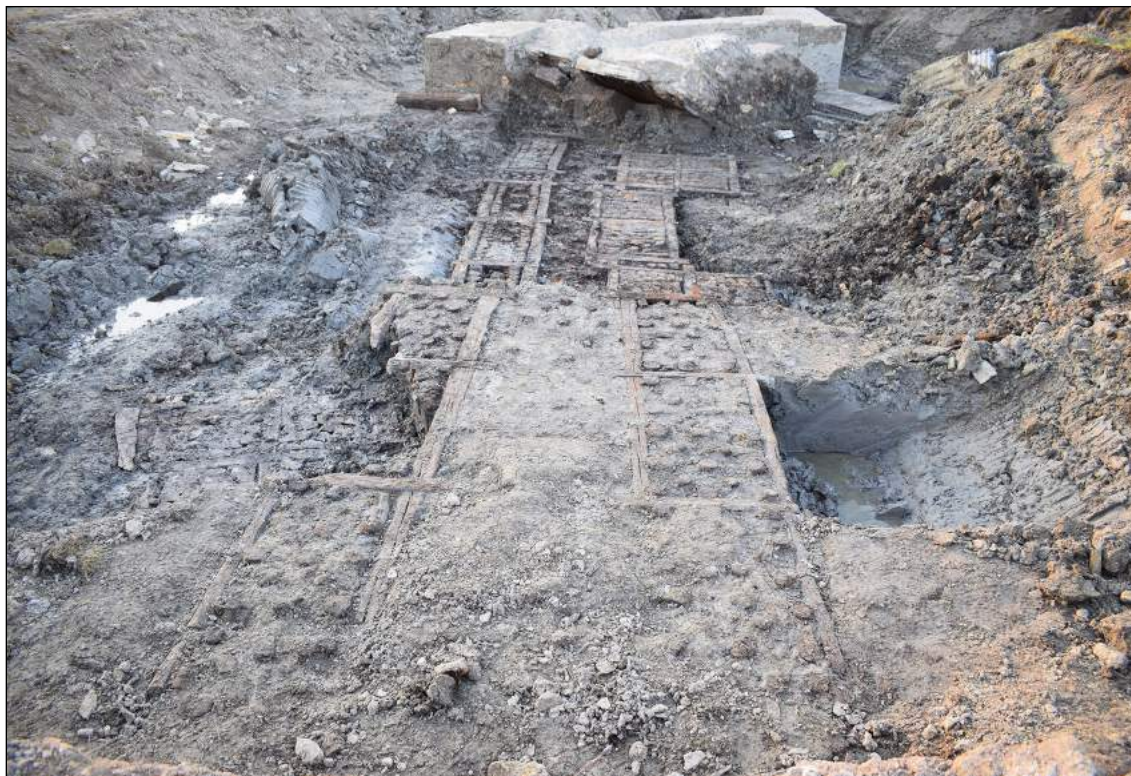
Afb. 4.24. Aan de linkerkant is zichtbaar dat een deel van de roosterfundering is weggebroken. Mogelijk hangt dit samen met de verbouwwerkzaamheden ten tijde van de vervijzeling.
