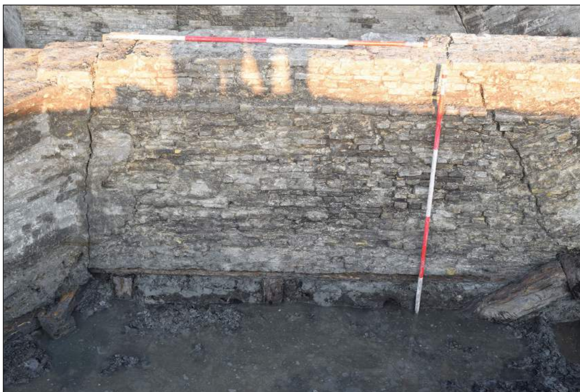
Afb. 4.41. Aan de buitenzijde van de vijzelbak was het metselwerk slordig.
