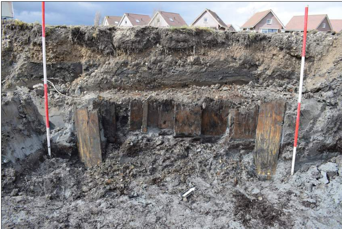
Afb. 4.31. Het noordelijker liggende kwelscherm S39 op de grens van de boezem naar de achterwaterloop.
