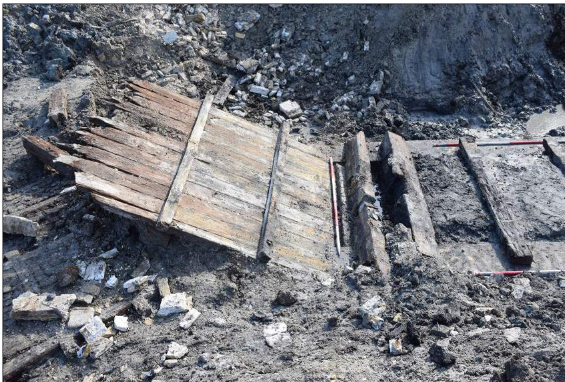
Afb. 4.46. De vloer van de vijzelkom met daarop de zwalpen.
