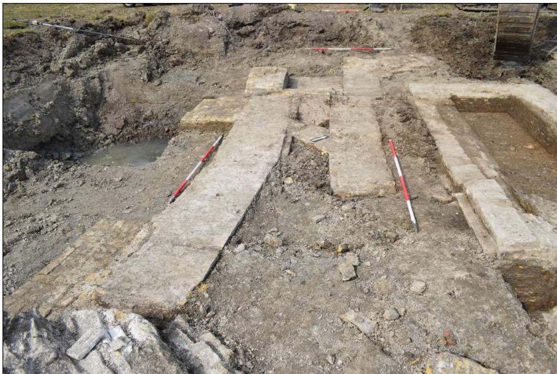
Afb. 4.20. De bakstenen opbouw van de krimp, de penanten, de opleider en de voorwaterloop.
