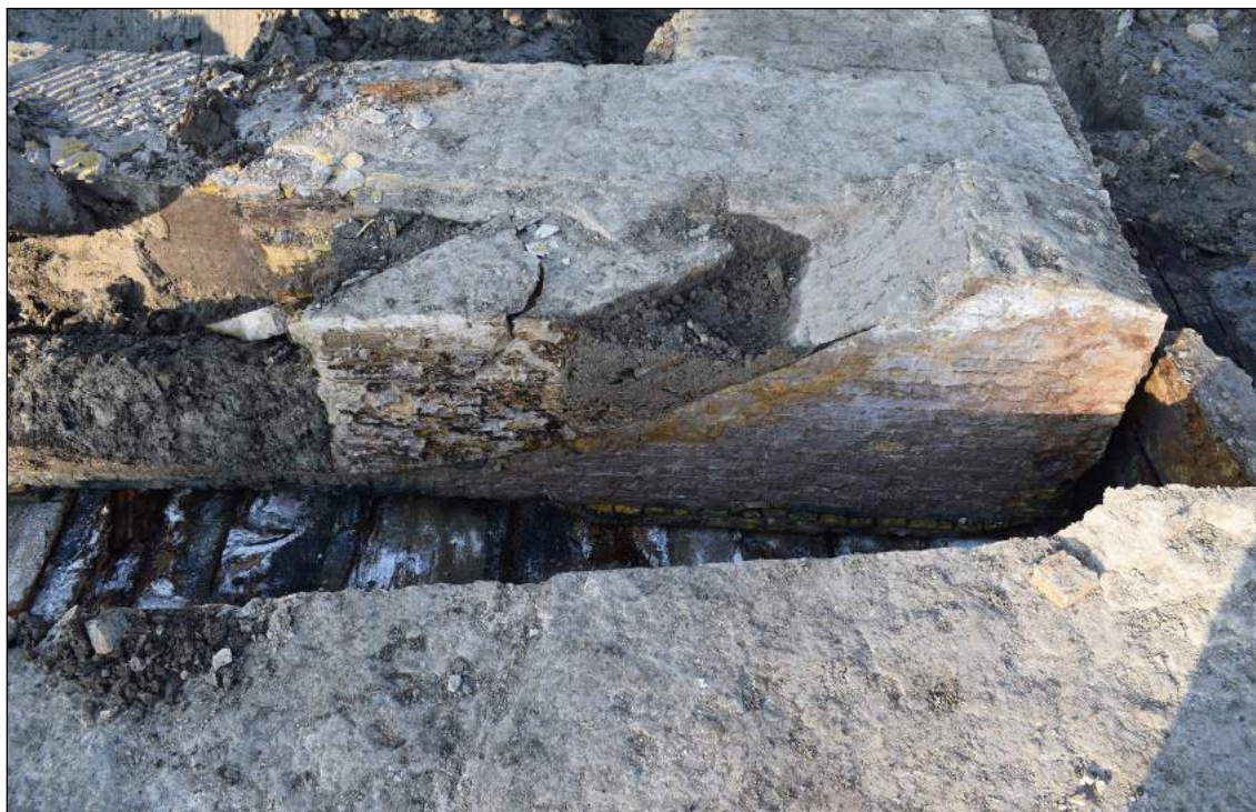
Afb. 4.21. Zijaanzicht van de opleider. De schuine muur in de opleider is van later en hoort bij de vervijzeling van de molen.
