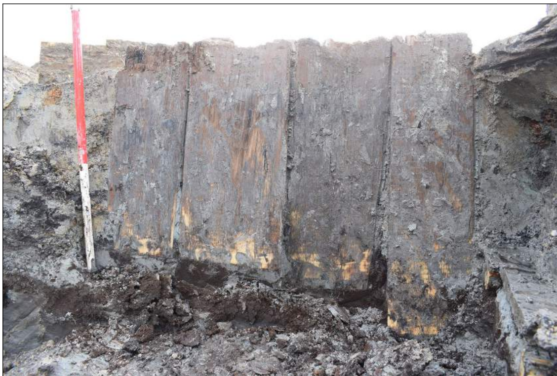
Afb. 4.30. De houten beschoeiing op de grens van de achterwaterloop en de krimp.
