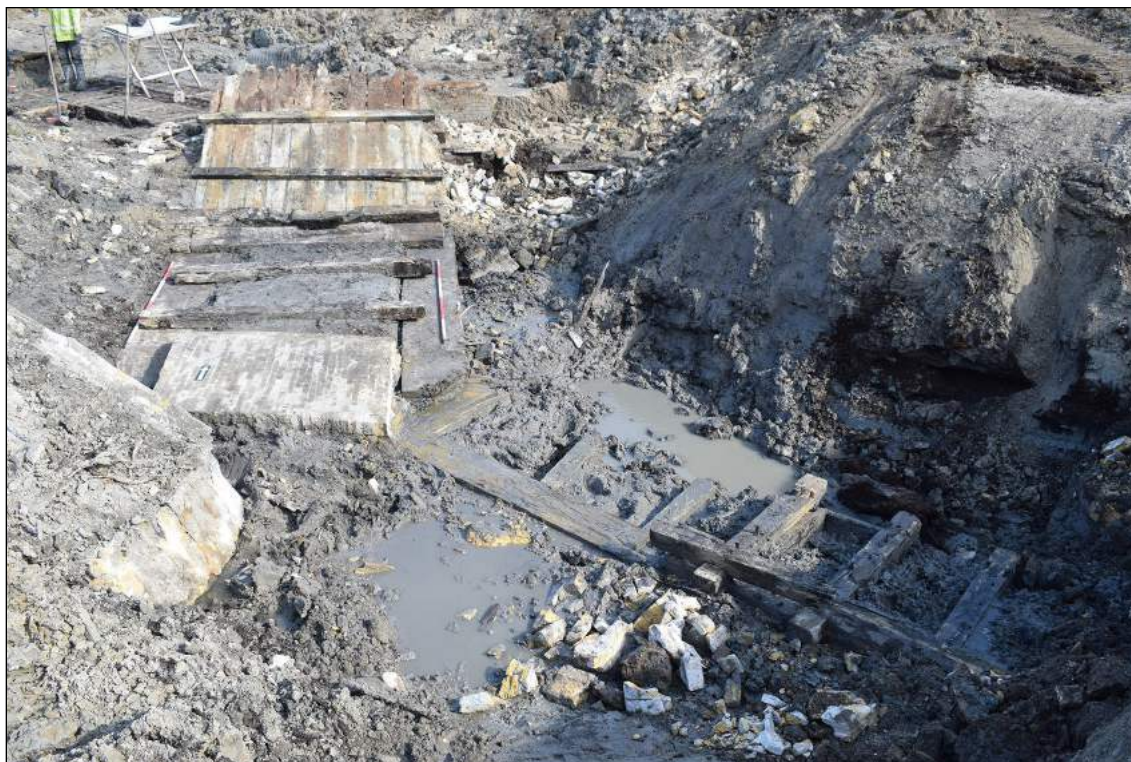
Afb. 4.48. De houten fundering van de vleugelmuur met de verhoging daarin.
