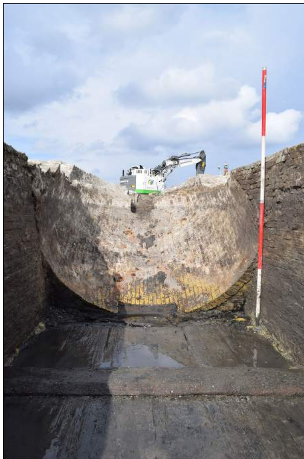
Afb. 4.47. De rond gemetselde vijzelkom was nog duidelijk zichtbaar.
