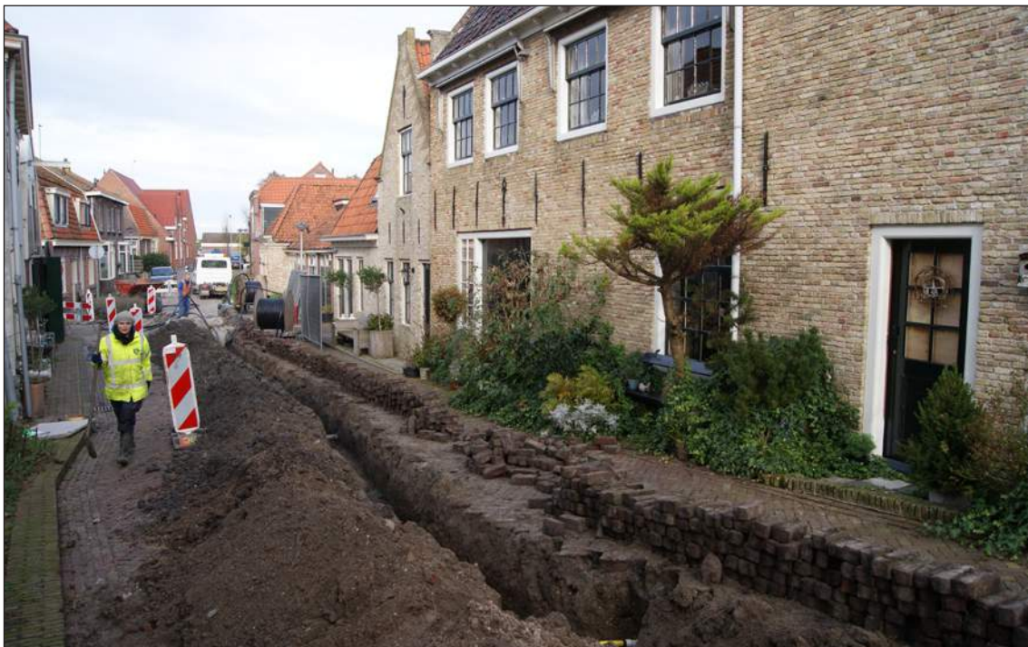
Afbeelding 21. Het zuidelijk deel van de Wijdesteeg was grotendeels verstoord door kabels en leidingen. Kijkend vanaf de Oosterhaven richting het noorden.
