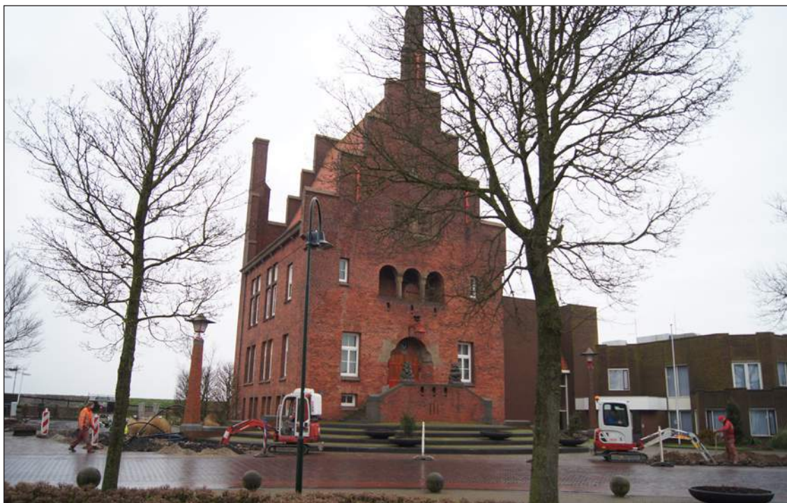
Afbeelding 12. Direct ten zuiden van het voormalige stadhuis werd een smalle sleuf aangelegd.
