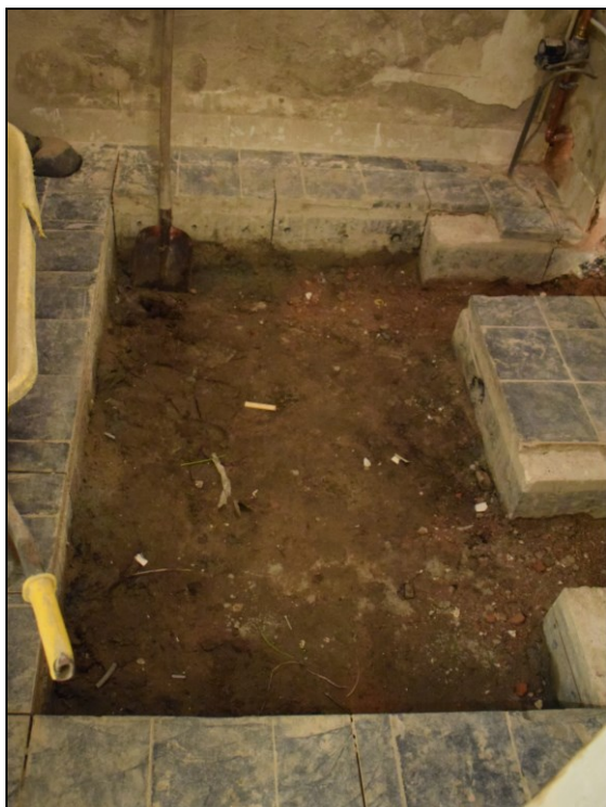
Afbeelding 10. De roodbruine puinlaag onder de betonnen vloer.
